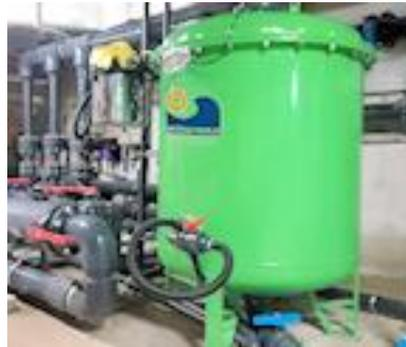
El sistema incluye un mecanismo manual de reposición de perlita que se empleará en cada nuevo ciclo de filtrado tras varias semanas de uso. El sistema de filtración recircula el agua de la piscina mediante el **grupo de bombeo de velocidad variable**, diseñado para optimizar el consumo de energía eléctrica, reducir el ruido y maximizar la vida útil de las bombas, el bombeo es redundante pudiendo funcionar incluso ante un eventual fallo temporal de una bomba.
