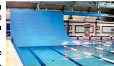
Enrollador fijo elevado, estructura metálica de aluminio lacado con tornillería y soportes de acero inoxidable, practicable de paso o circulación inferior, con altura de paso mínima de 2,20 m, motorizado con finales de carrera regulables de paro inicial y final.
